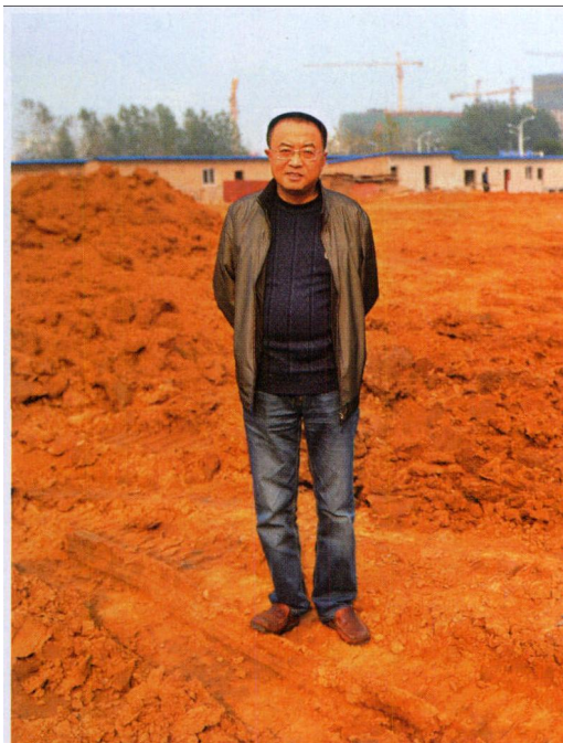
王欣在镇江市档案馆新馆工地
