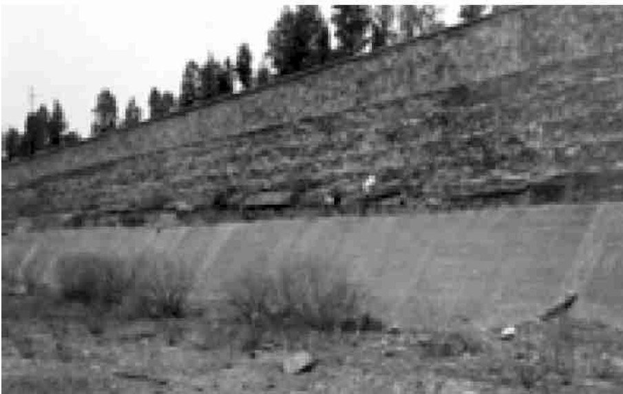
清代永定河河堤遗迹
