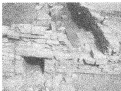
图 4 暗排水沟上侧的明排水沟
