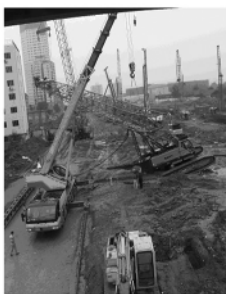
图2 履带吊大臂折断
