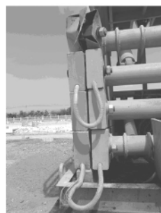
图3 剪叉节变形开裂
