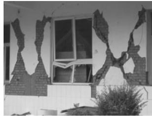
图4 配置RC扶壁柱的窗间墙震害
