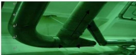
图 4 改造后的二段进口补气管线与二段入口管线
