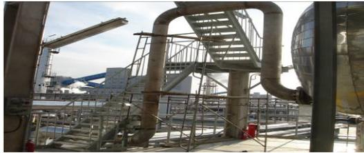
图 3 改造后的二段防喘振管道 U 型液封
